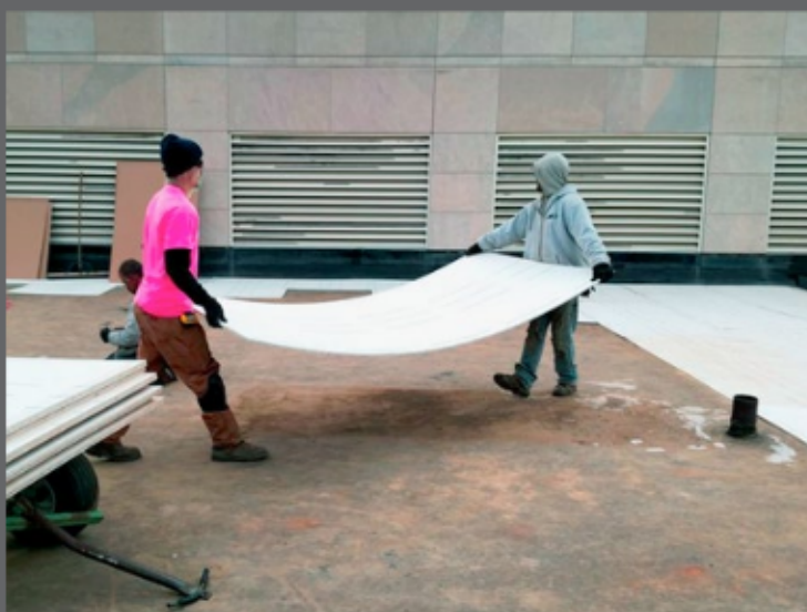
Плиты используются для потолочной системы крыш, обладают высокой гибкостью и устойчивы к механическим повреждениям (например, граду)
