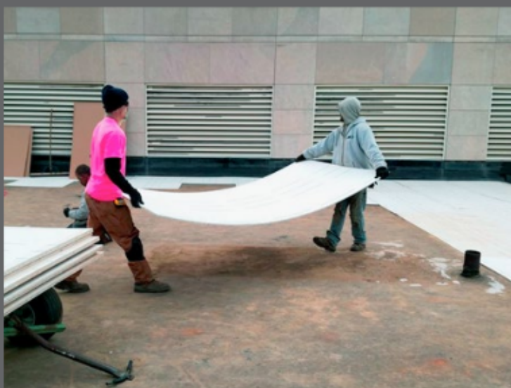
Desky se používají pro stropní systém střech, jsou vysoce pružné a odolné proti mechanickému poškození (např. krupobití)
